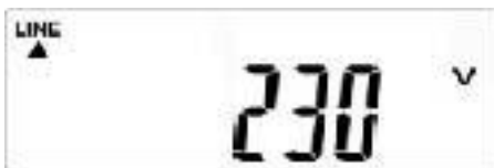
Abb. 7-4 – 12 Anzeige R – Photovoltaik-Wechselrichter Ausgangsspannung
