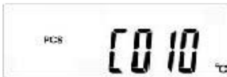
Abb. 7-4 – 2 Anzeige H – Photovoltaik-Wechselrichter Innentemperatur °C
