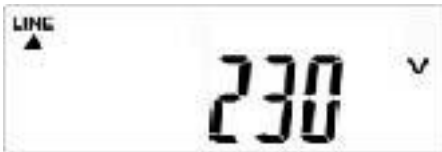
Abb. 7-4 – 12 Anzeige R – Photovoltaik-Wechselrichter Ausgangsspannung
