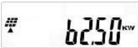
Abb. 7-4 – 11 Anzeige Q – Ausgangsleistung Strang B
