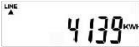
Abb. 7-4-1 Anzeige G – Gesamte Einspeiseleistung
