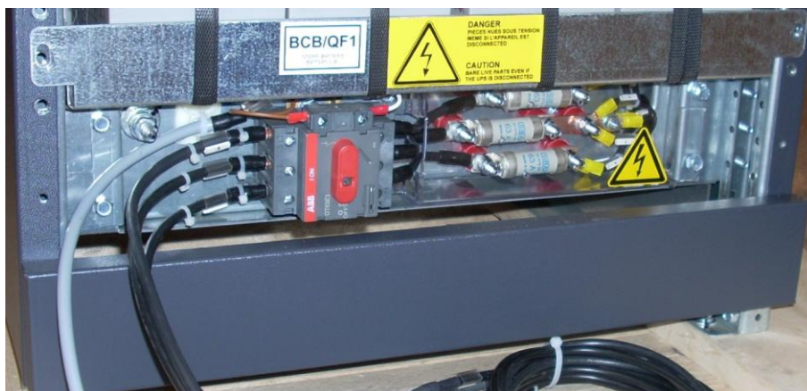
Bild 21 –Position Batterie Trenner und Batterie Sicherung
